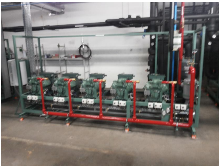
Instalacja na R744, Źródło: www.sklep.frigopolska.pl
